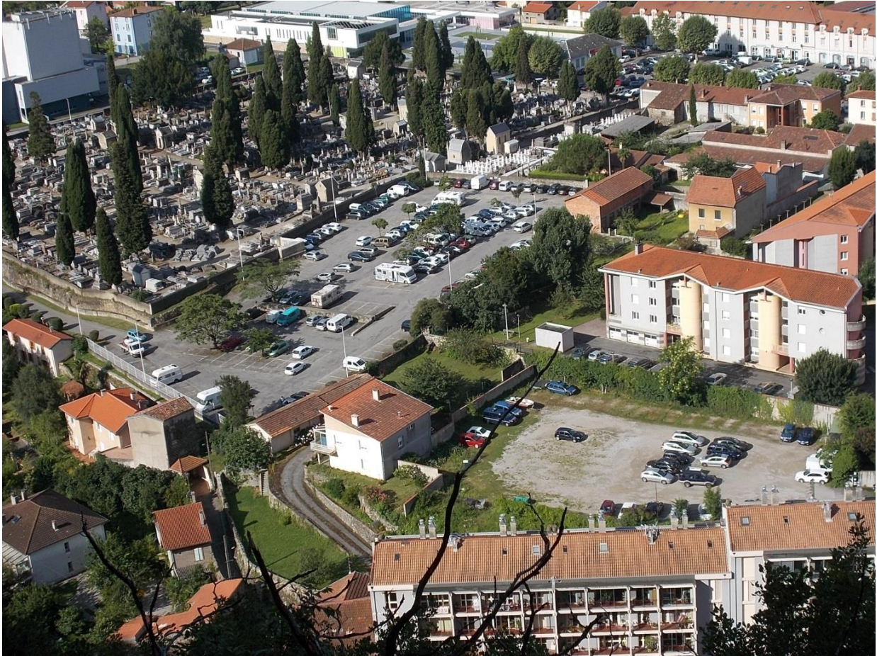
Vue du parking de la Vigne
