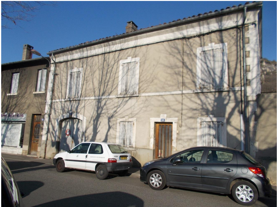
Immeuble de la conciergerie du cimetière
